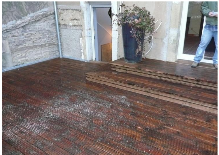
Holzbelag auf Terrasse
