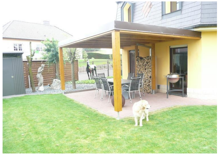
Anbau aus Kvholz , Flachdach in Evalon
