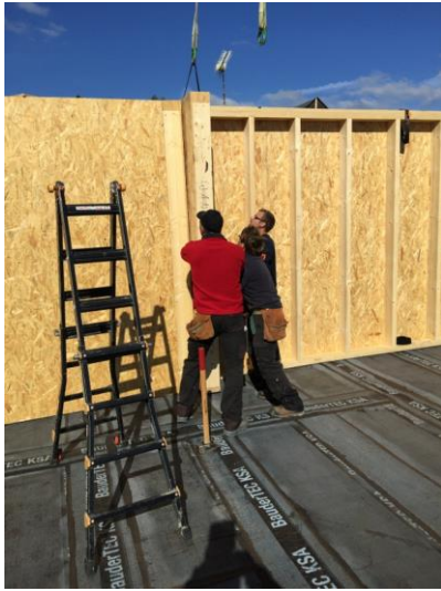
Montage de murs
