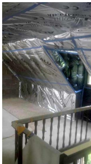
Isolierung mit Dampfsperre
