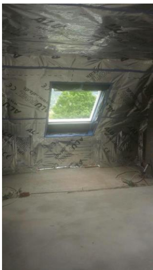
Isolation avec pare vapeur
